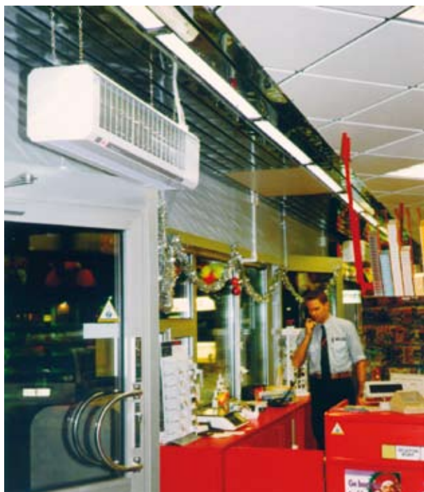
Aufhängung an der Decke mittels Pendel.
