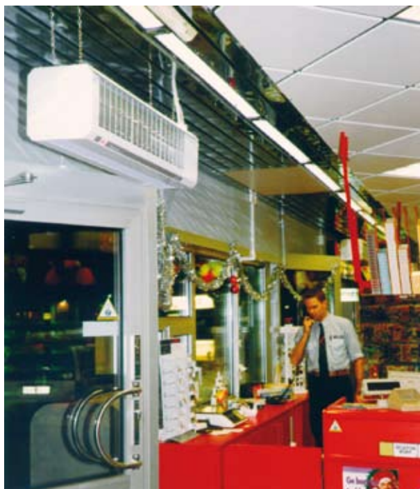
Aufhängung an der Decke mittels Pendel.
