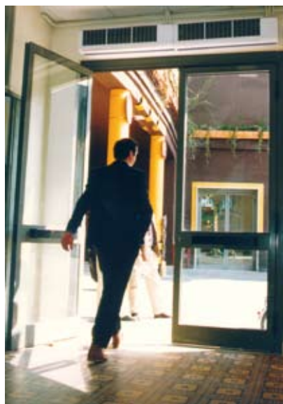
Montage mehrerer Geräte nebeneinander, um verschiedene Türbreiten abzudecken.
