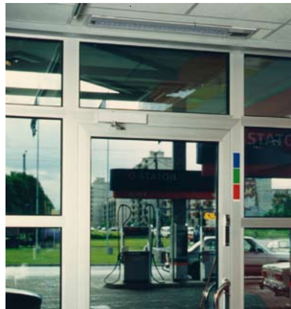
Montage in einer Zwischendecke
